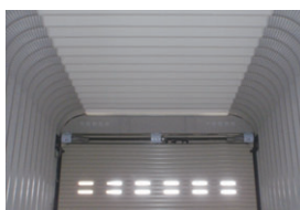
※天井結露軽減材施工例
