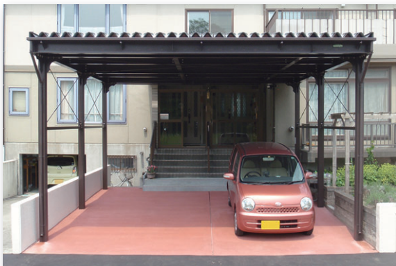
▲ 特注ヤマト型ロング柱 施工例
