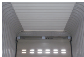
※天井結露軽減材施工例
