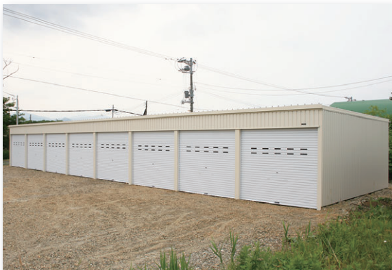
▲ セラフィ多連棟型 施工例
