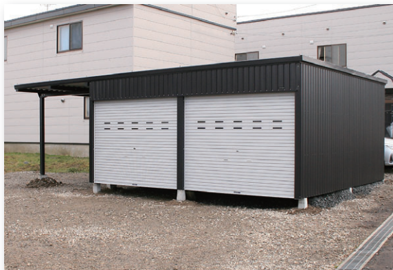
▲ セラフィ2連棟C+1型 施工例
