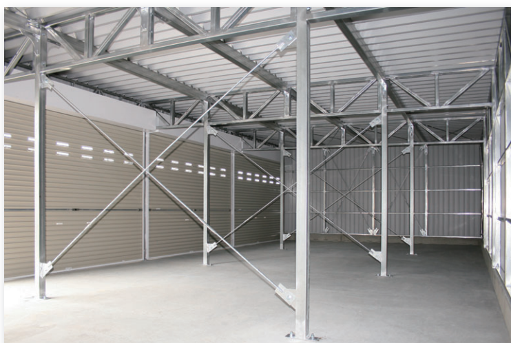
▲ セラフィ多連棟型 施工例
