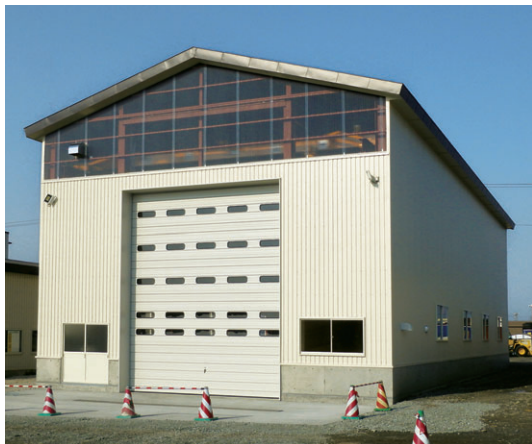
▲ 切妻タイプ 妻面10.8m×桁行き25.2m
