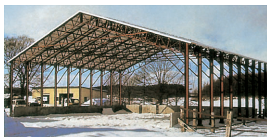
▶ 切妻タイプ 妻面12.6m×桁行き35.6m
