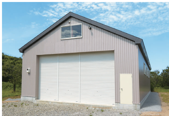
▲ 切妻タイプ 妻面10.8m×桁行き18m
