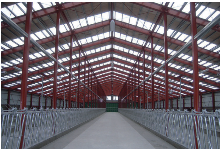
◀ 切妻タイプ 妻面23m×桁行き74m
