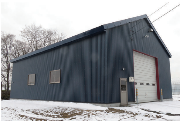
▲ 切妻タイプ 妻面10.8m×桁行き18m
