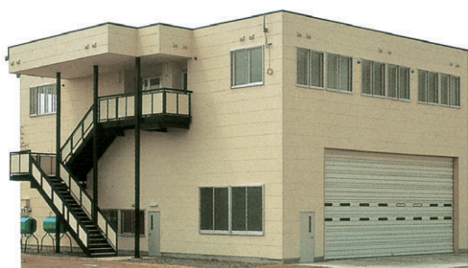
▲ FRタイプ 妻面18m×桁行き12m
