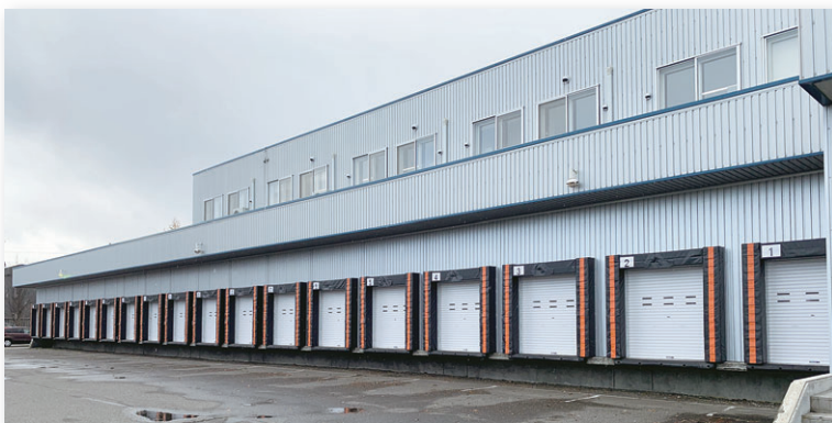
▲ ストックヤード改修 施工例
