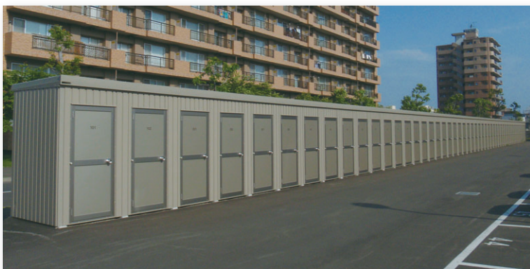
▲ ロゼッタD型多連棟 施工例
