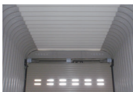
※天井結露軽減材施工例
