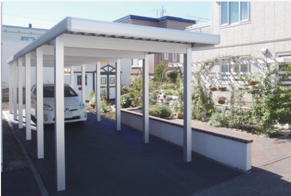
▲ ファインスペース型 奥行延長 施工例
