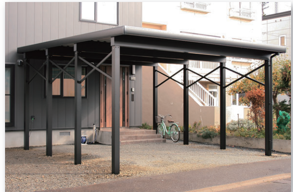
▲ ツインスペース型 8本柱 クロス梁付き 施工例
