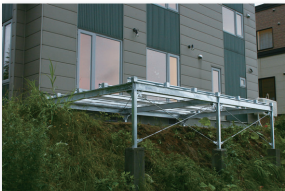
▲ ヤマト型特注架台 施工例 (木部は別途工事)
