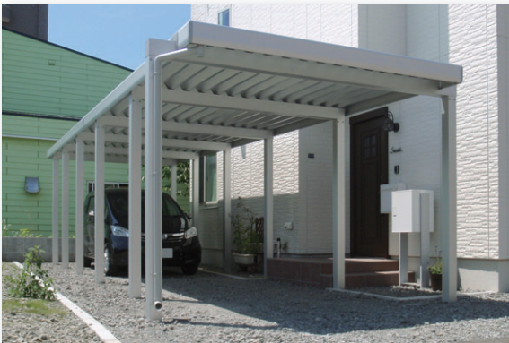
▲ ファインスペース型 奥行延長・特注幅 施工例
