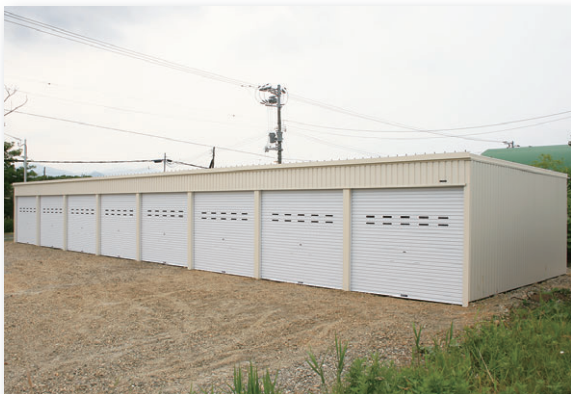
▲ セラフィ多連棟型 施工例
