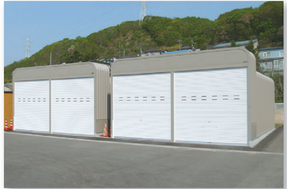
▶ 丹頂プル2連棟型 施工例
