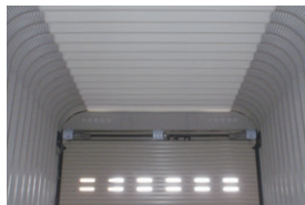
※天井結露軽減材施工例
