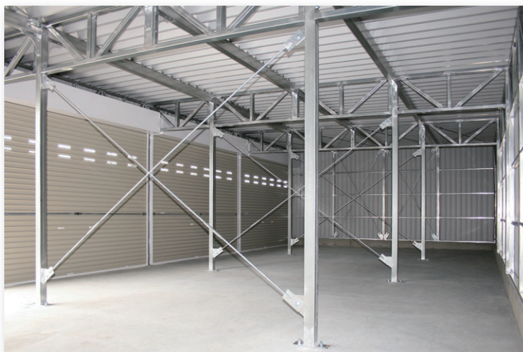
▲ セラフィ多連棟型 施工例
